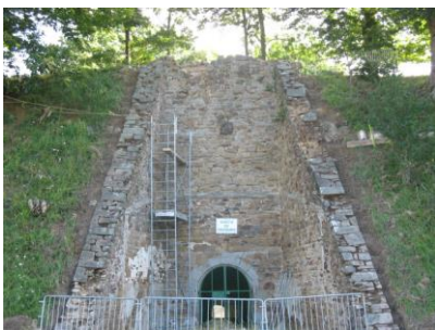
La poterne : Dessouchage et déracinage de la végétation avant réfection de la maçonnerie du haut de la poterne
